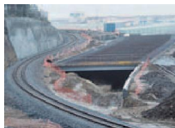
Construyen la estructura sobre la que se asentará la vía férrea.
